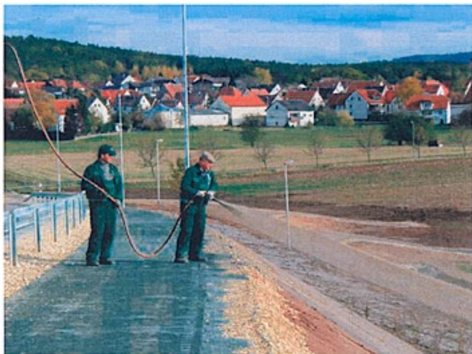
Ausbringung der Nassansaat, anschließend erfolgt die Abdeckung mit Strohmulch – unterschiedliche Arbeitsgänge gewährleisten nach Lintl den Erfolg der Begrünungsmaßnahme.
